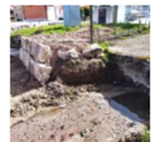
49. Corregir las aguas grises y de alcantarillado
