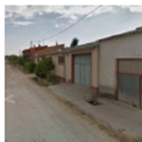
44. Asfaltar carretera de los merenderos
