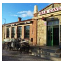
17. Ventanas con puente térmico en Bar de Cavia
