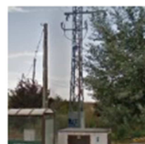
35. Aislar los transformadores de alta/baja tensión
