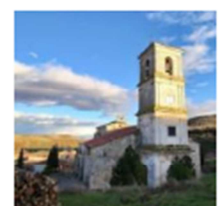
45. Cambio de cubierta de tejado de la Iglesia de Cavia del 2.020
